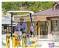
2011.5.18保育園前の土砂撤去
