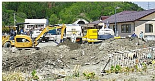
土砂の積込み(2011.5.18)
