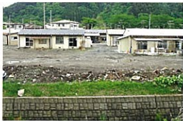
作業終了時の状況(2011.5.22)
