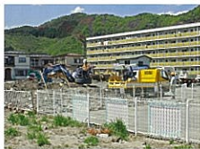
作業開始の頃の状況(2011.5.18)
