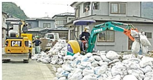
土砂の積込み(2011.5.20)
