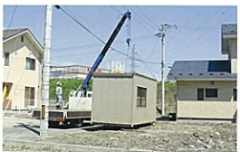
倉庫の吊り上げ作業(2011.5.18)
