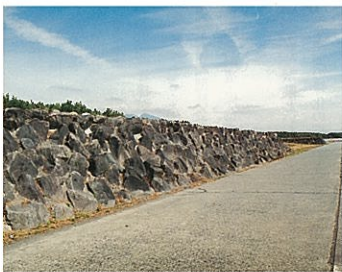
田子浦港土留め
