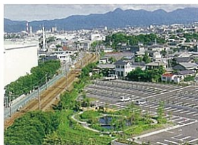
駐車場とビオガーデンの建設(東洋インキ製造(株)富士製造所)
