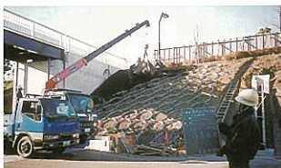
静岡(富士)緑地造園工事現場
