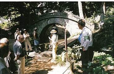
アーチ橋の説明(後樂園にて)
