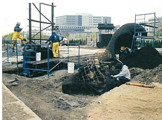
躯体製作の様子
