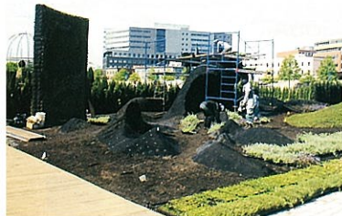
製作完了の躯体に植え込みを行なう
