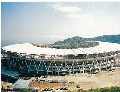
建設中の小笠山総合運動公園
