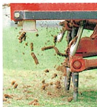
鉄パイプから放り出される土は柱状
